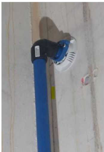
Abb. 1: Einzelspartenhauseinführung
